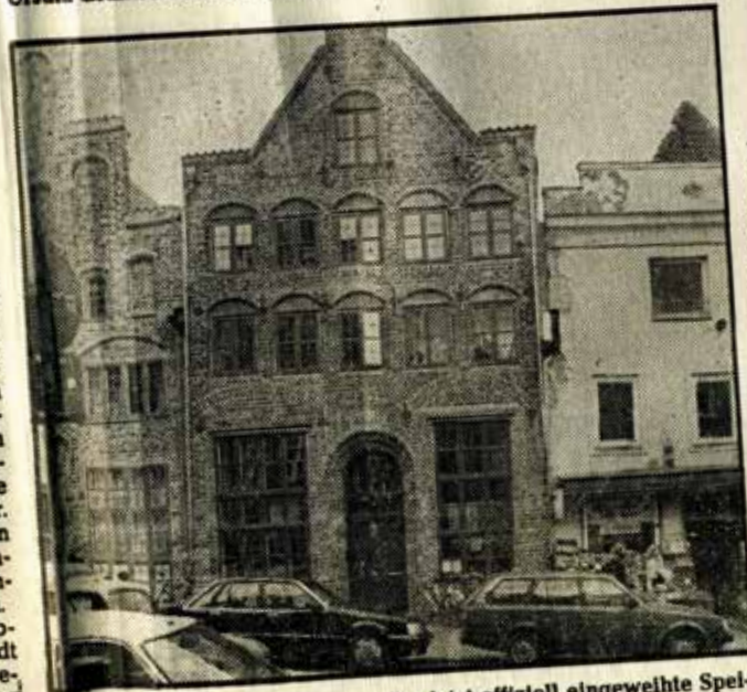
Im neuem Glanz präsentiert sich der jetzt offiziell eingeweihte Speicher der Brücke in der Engelsgrube.
